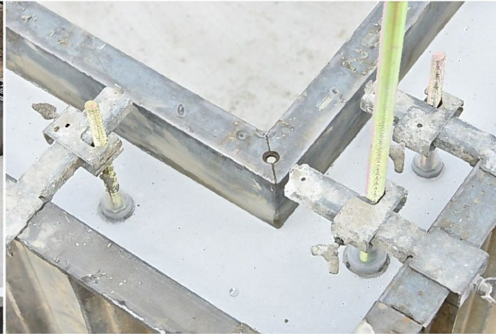
脱枠時(コンクリート・レベラー硬化後)の状況
