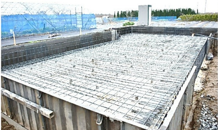
作業途中の全景
