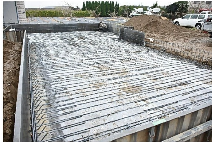
作業途中の全景
