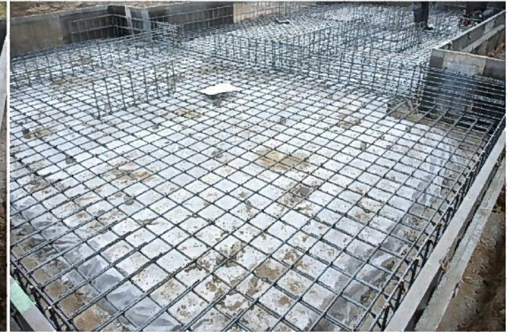
基礎鉄筋配筋完了②(全景)
