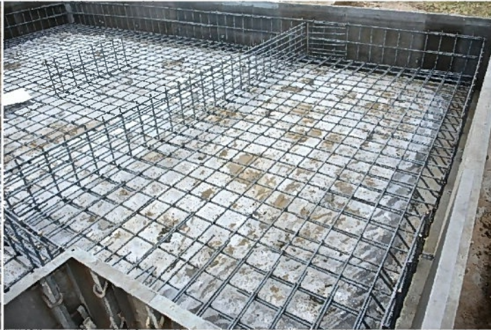
基礎鉄筋配筋完了①(全景)
