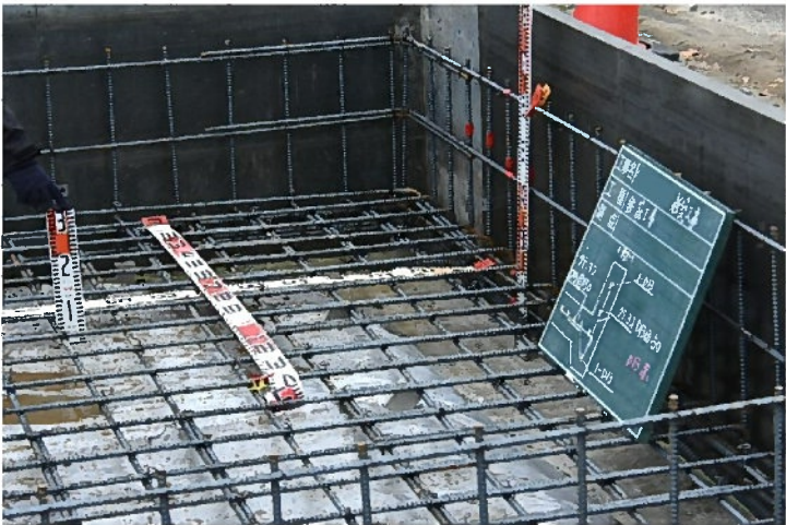
鉄筋ピッチの確認①
