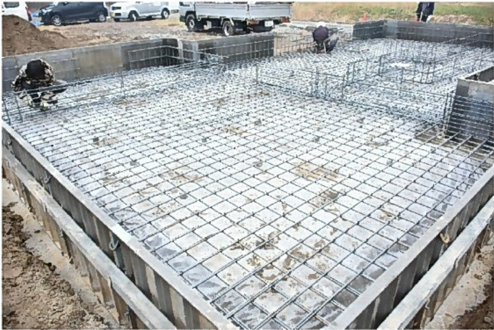
間仕切り基礎鉄筋の組み立て④
