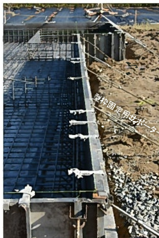
型枠の通りとアンカーボルト固定金具の取付
