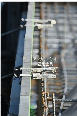
型枠の通りとアンカーボルト固定金具の取付
