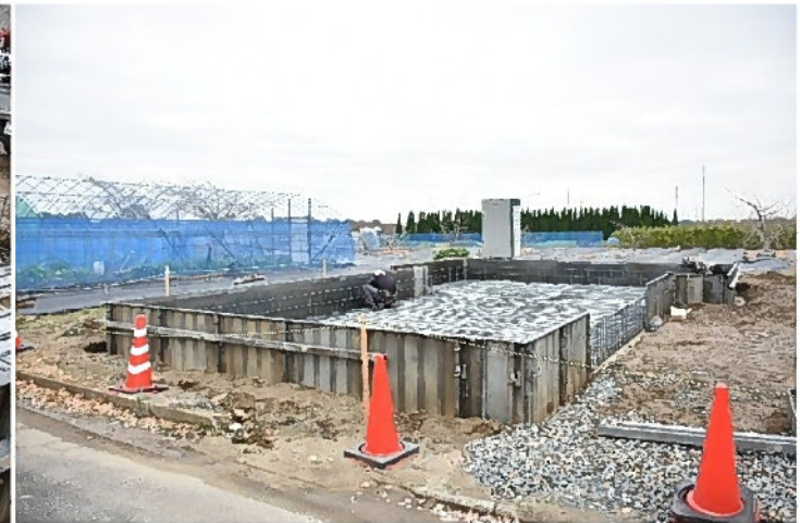
作業途中の全景
