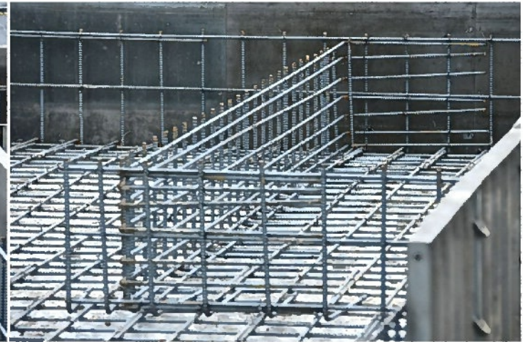
補強のための鉄筋追加箇所②
