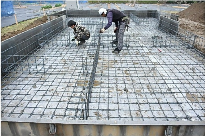
間仕切り基礎鉄筋の組み立て⑤
