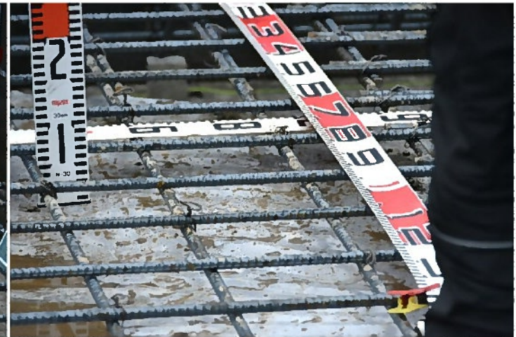
鉄筋ピッチの確認③
