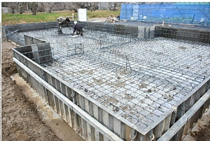
間仕切り基礎鉄筋の組み立て②
