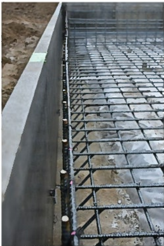
基礎鉄筋配筋完了③(外周立ち上がり部)
