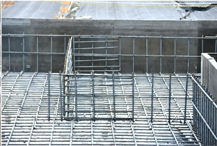
補強のための鉄筋追加箇所①
