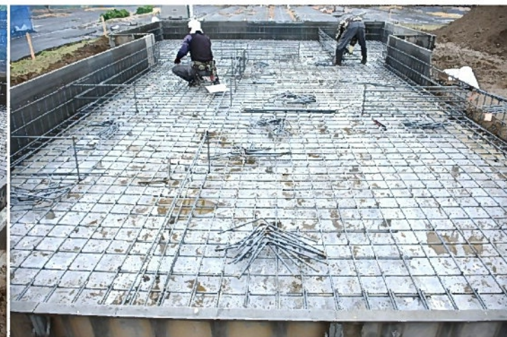
間仕切り基礎鉄筋の組み立て③
