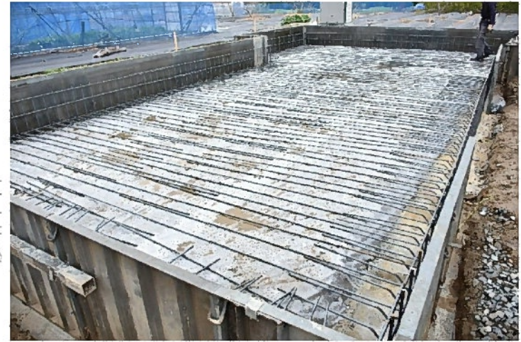
作業途中の全景
