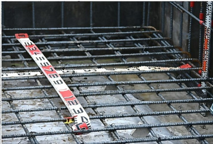
鉄筋ピッチの確認②
