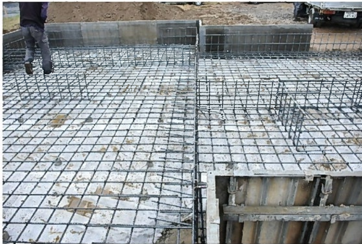
基礎鉄筋配筋完了④(間仕切り部)
