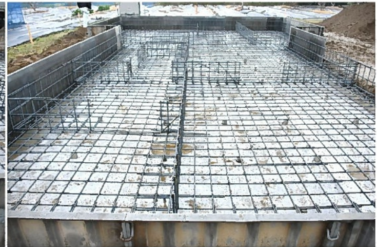
基礎鉄筋配筋完了⑤(全景)
