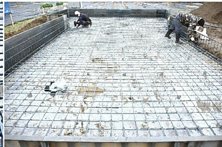
耐圧盤の鉄筋組み立て完了
