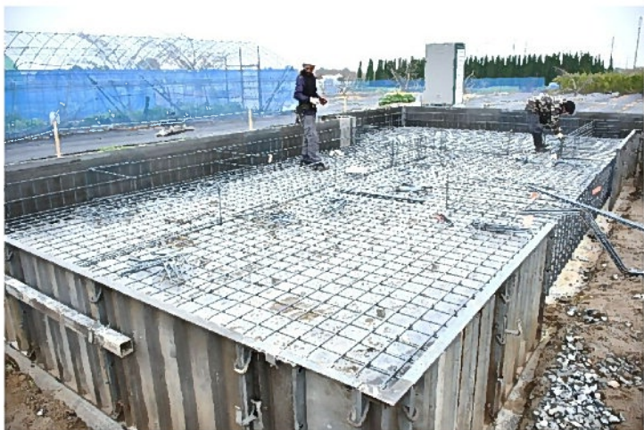
間仕切り基礎鉄筋の組み立て①
