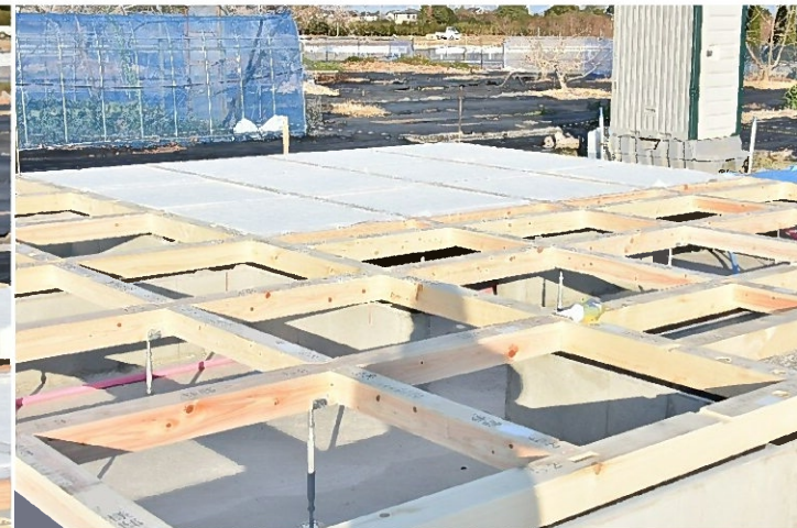
断熱材の敷込③ 断熱材敷込途中の状況です。
