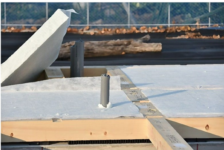
断熱材の敷込④ 給排水の配管立上り部分については、断熱材を切り欠いて貫通させていきました。
