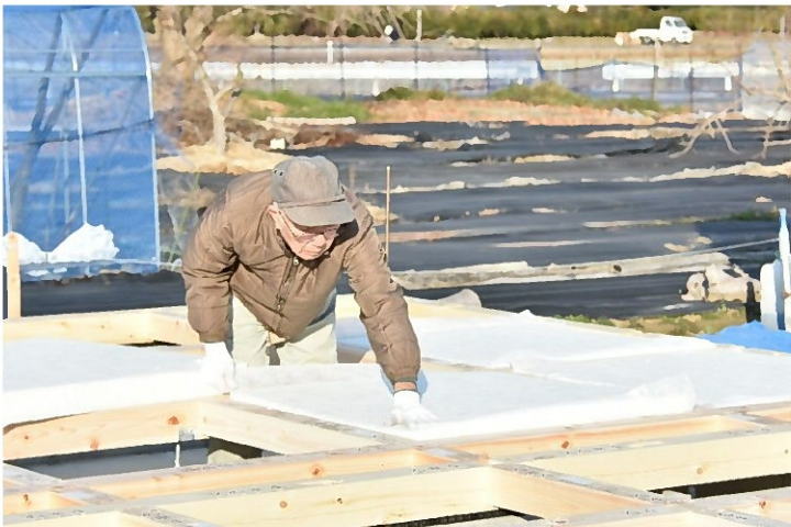
断熱材の敷込① 土台・大引で囲われた口の字の部分に断熱材を敷き込みました。
