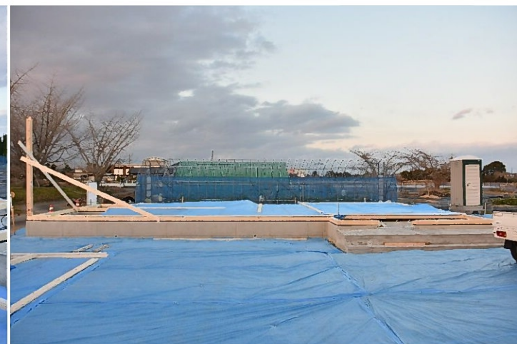
断熱材の敷込⑦ 作業終了時の全景です。
