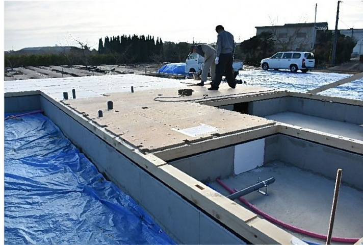
床下地合板の施工② 1階床下地の合板(ア)24mmを敷いていきました。
