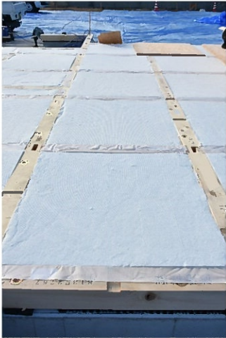
土台・大引・断熱材 断熱材施工後の状況です。
