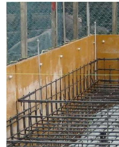
**基礎打設直後の硬化前のコンクリートに差し込むこと(田植え)は、絶対に不可です！必ず上記の様な方法でアンカーボルトが取り付けられている事を確認してください。**
