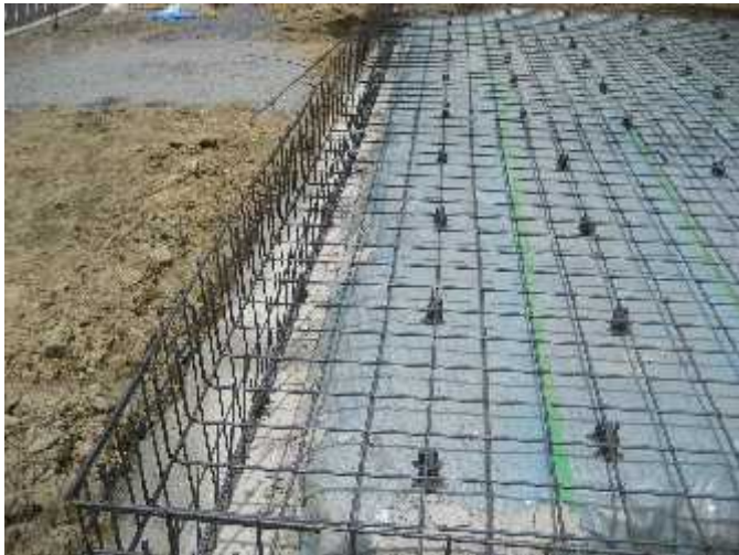
ベタ基礎の配筋状況
