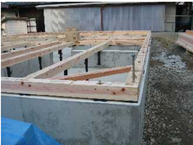
土台設置状況
