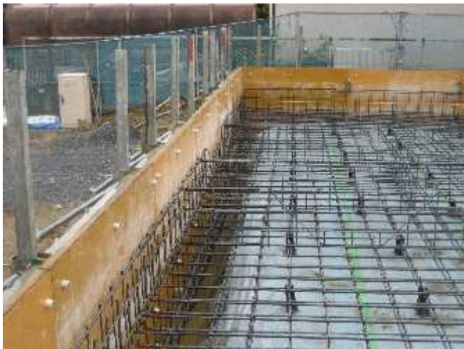
型枠施工とM16アンカーボルト取付け
