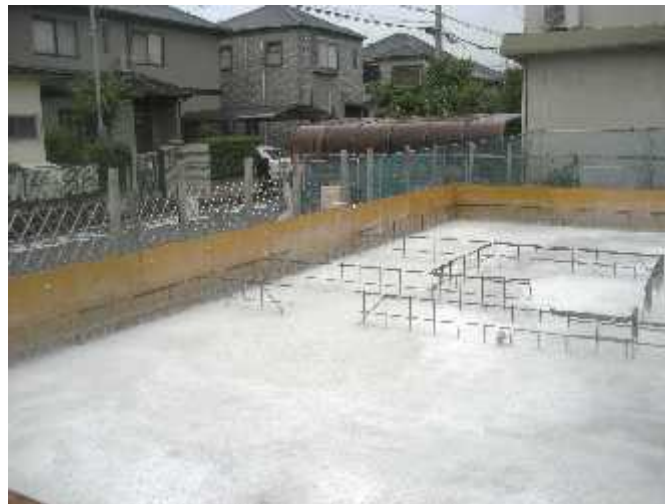
ベースコンクリート打設
