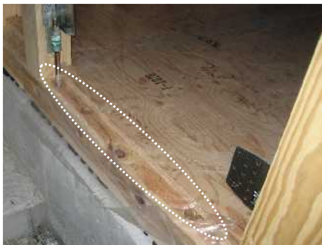
床下地の合板とアンカーボルトの取り合い
