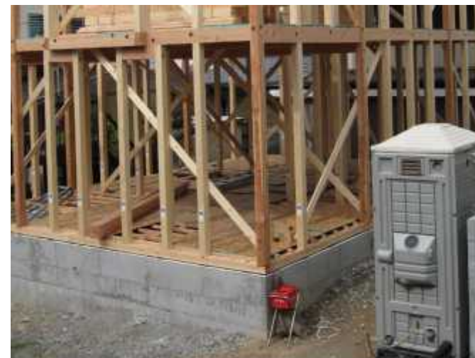
柱・梁の建て込み
