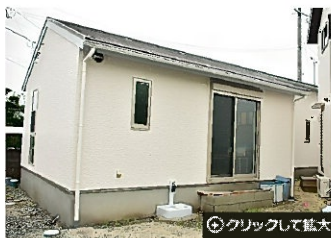
完成して2カ月で不同沈下した住宅Bの外観。液状化で1000分の19に傾き、沈下量は最大260mmに達した。被害認定は大規模半壊になった (写真: WASC基礎地盤研究所)
