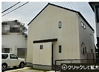
不同沈下した築3年の住宅Aの外観。沈下量は最大90mmに達した。被害認定は大規模半壊になった (写真: WASC基礎地盤研究所)
